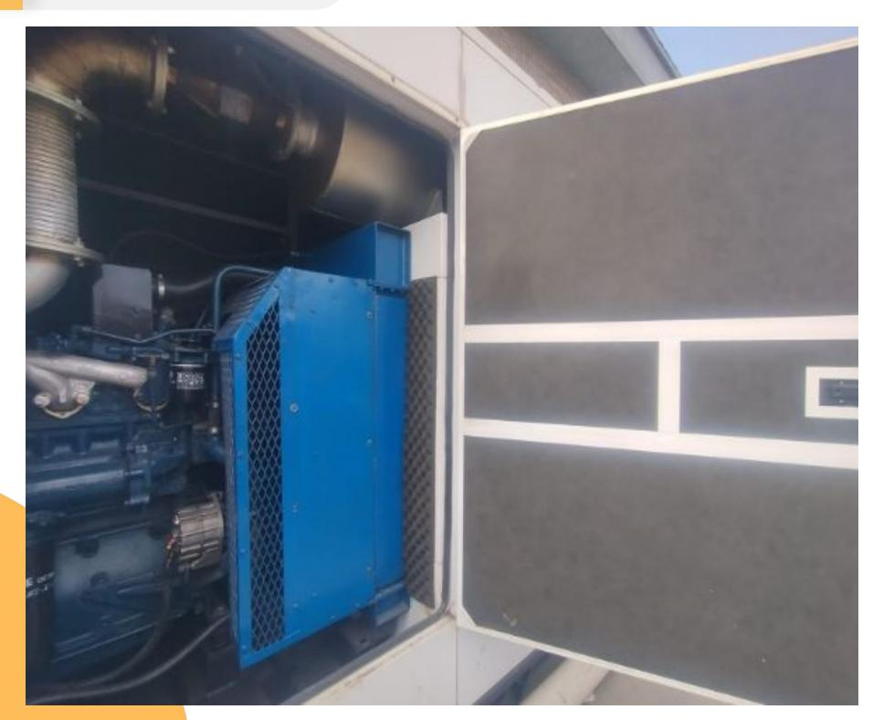
**Observação:** tratamento acústico - forro interno antiruído. Não há vizinhança por perto dispensando a necessidade de Relatório MNPS.
